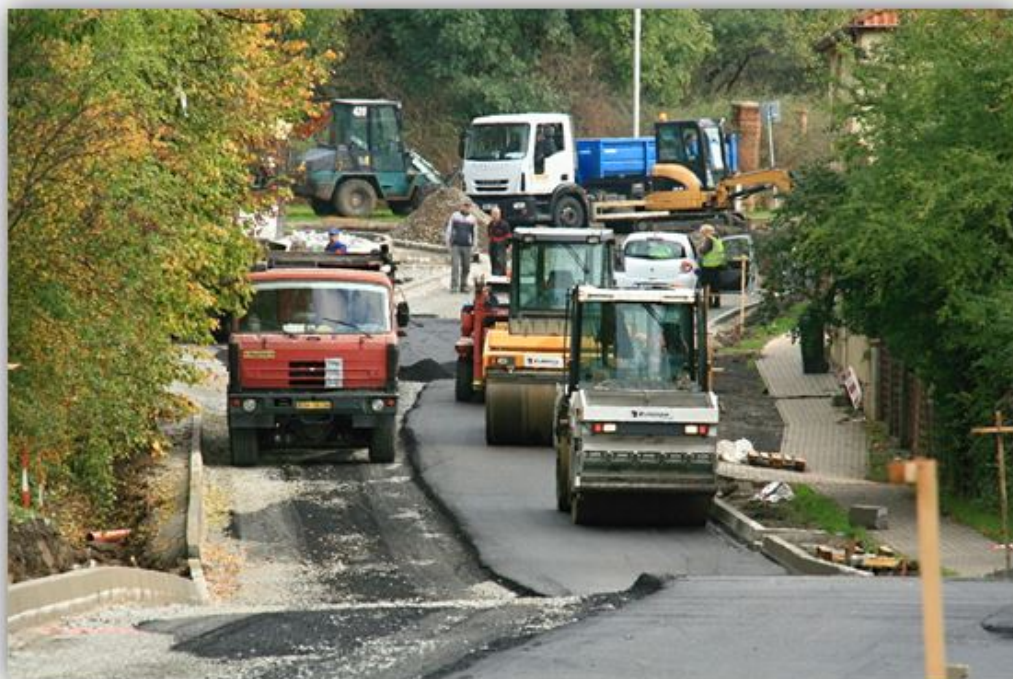
11 POKLÁDKA ASFALTOVÉ VRSTVY
