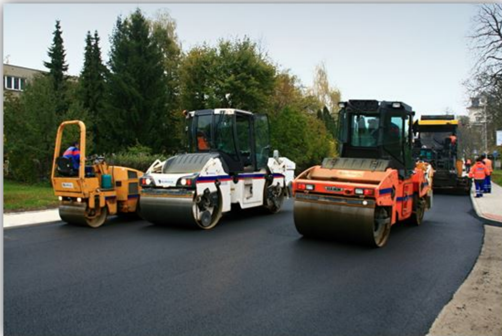
13 KONEČNÁ ÚPRAVA VOZOVKY
