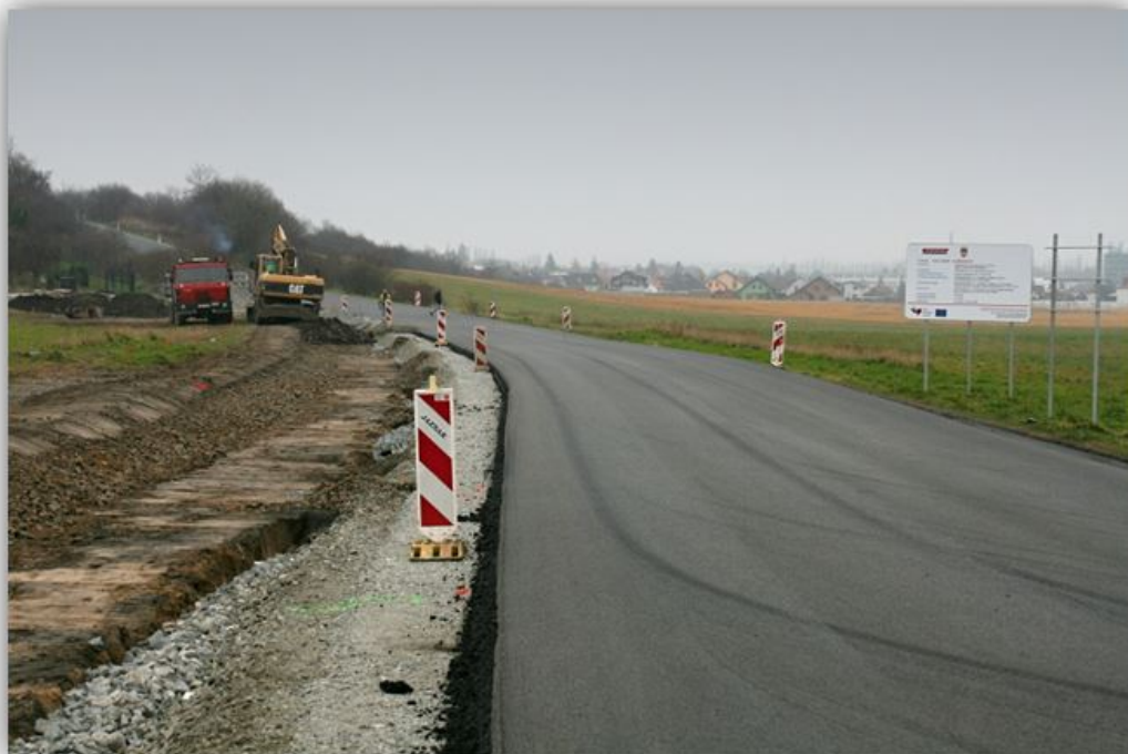
5 ZDE JEŠTĚ BUDE DOST PRÁCE
